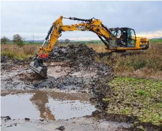
Abbildung 122: Regelmäßiges Ausbaggern von Amphibiengewässern ist notwendig, um die natürlichen Verlandungsprozesse zurückzusetzen und die Eignung für Amphibien dauerhaft zu gewährleisten. Hier wird ein Laub- und Grasfrosch Laichgewässer an den ‚Rauwiesen‘ zwischen Schröck und Roßdorf entschlammt.
