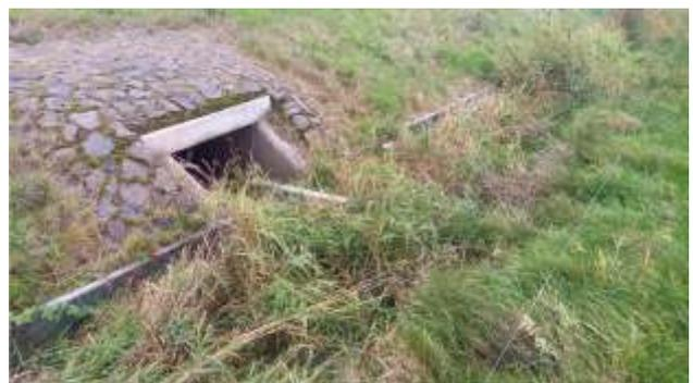
Abbildung 119: Stationäre Amphibienschutzanlage aus Metallzaun und Rechteck-Betontunneln (hier: an der K 84 zwischen Sterzhausen und Wetter).
