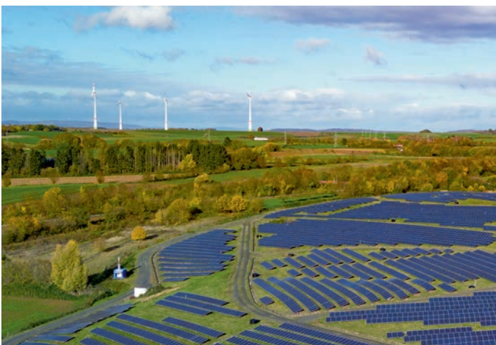
Der Ausbau der erneuerbaren Energien geht stetig voran.
