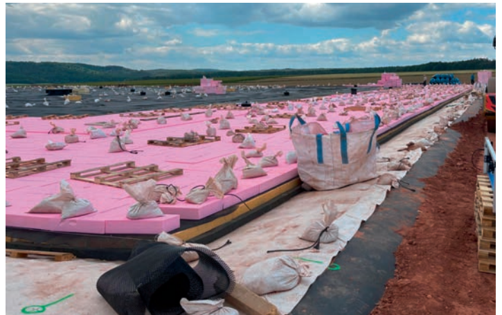
Die ersten Elemente der XPS Pyramide sind schon verlegt. Auf die dicken Platten kommen noch dünnere mit zunehmender Mächtigkeit zur Mitte hin. Links im Bild sieht man das „Mannloch“, das die Mitte des Speichers markiert. Bis hierhin sollen die XPS Platten ansteigen.
