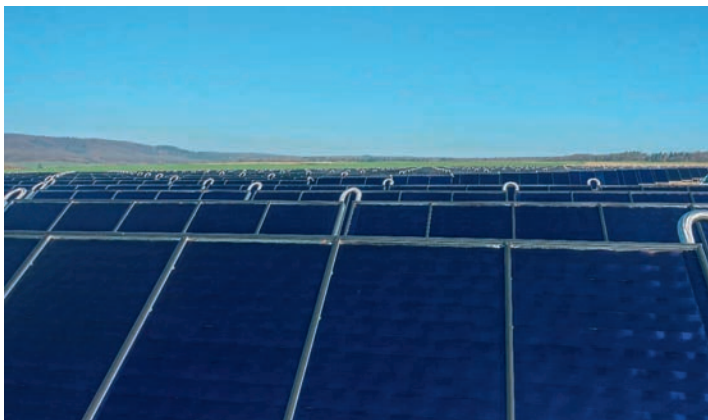
Thermische Solarkollektoren. Hier läuft das Wasser durch die Kollektoren und wird erhitzt. Dass es keine Photovoltaik ist, erkennt man an den Verbindungsschläuchen.
