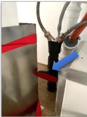
Bild 26: Öffnen des Wasser-Haupt- hahnes unter der Spüle
