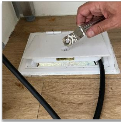
Bild 2: Öffnen und Schließen der Bodenklappe mit 4-Kant-Schlüssel
