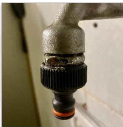
Bild 4: Trinkwasseranschluss außerhalb des Spülmobils
