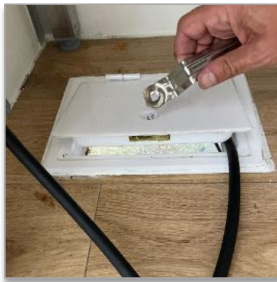
Bild 2: Öffnen und Schließen der Bodenklappe mit 4-Kant-Schlüssel
