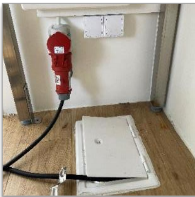
Bild 1: 16 A Anschluss im Spülmobil
