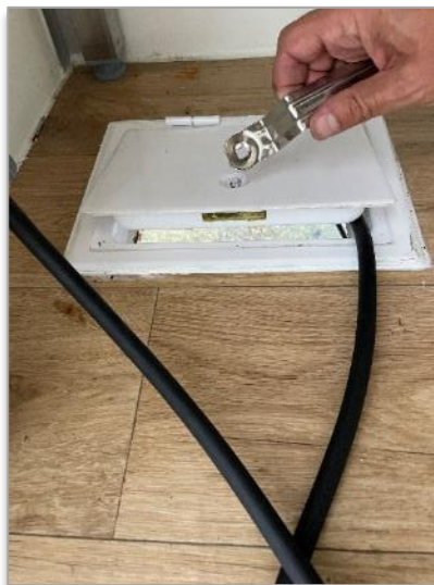
Bild 2: Öffnen und Schließen der Bodenklappe mit 4-Kant-Schlüssel
