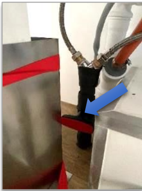
Bild 26: Öffnen des Wasser-Haupt- hahnes unter der Spüle
