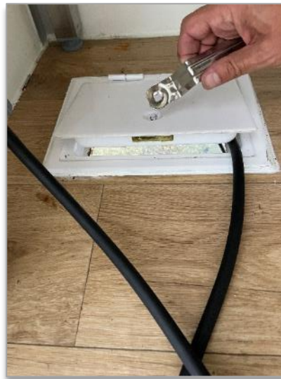
Bild 2: Öffnen und Schließen der Bodenklappe mit 4-Kant-Schlüssel
