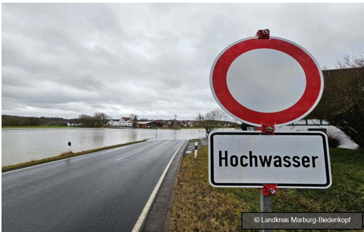
Abbildung 12: Unwetterereignis Gemeinde Weimar 2023. Bildquelle: Landkreis Marburg-Biedenkopf.
