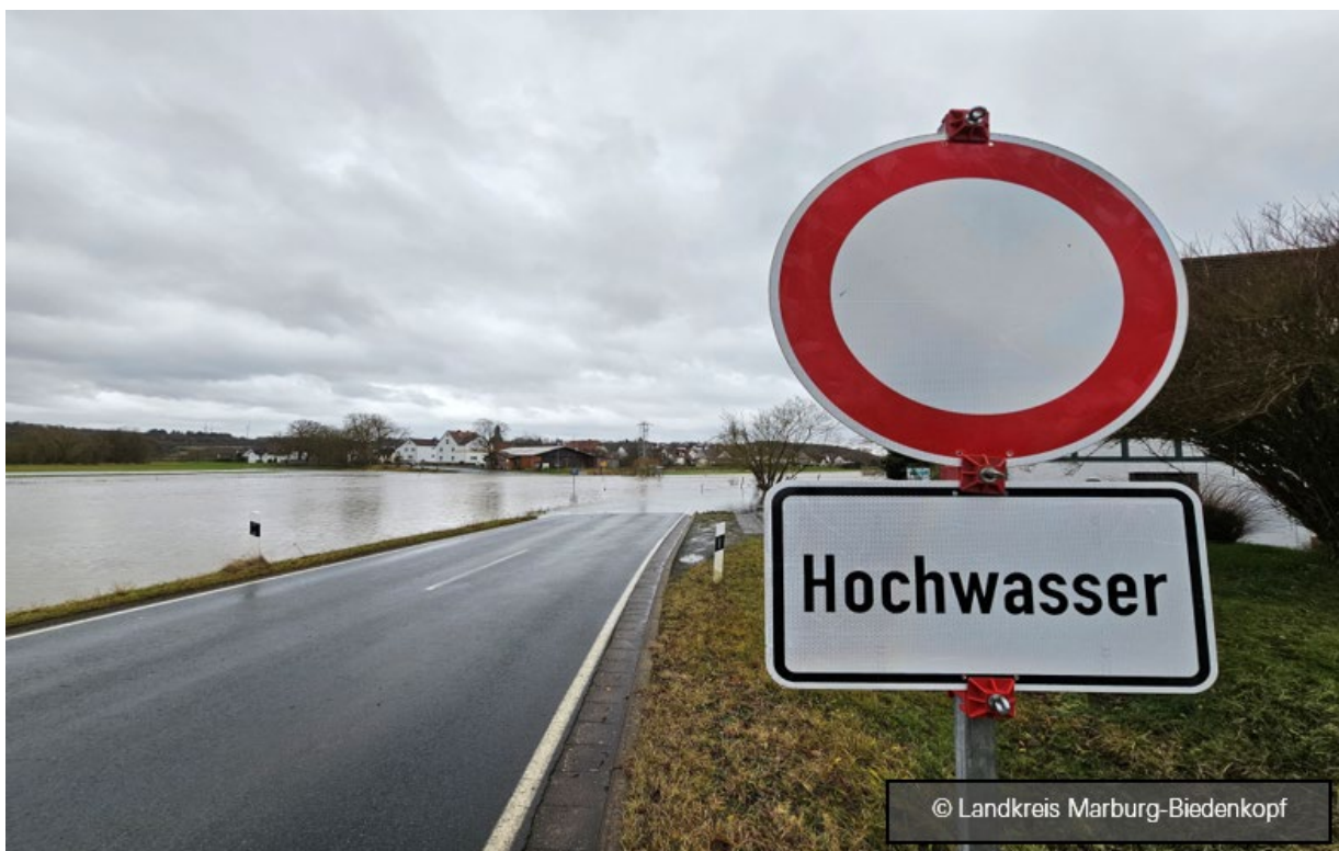
Abbildung 12: Unwetterereignis Gemeinde Weimar 2023. Bildquelle: Landkreis Marburg-Biedenkopf.
