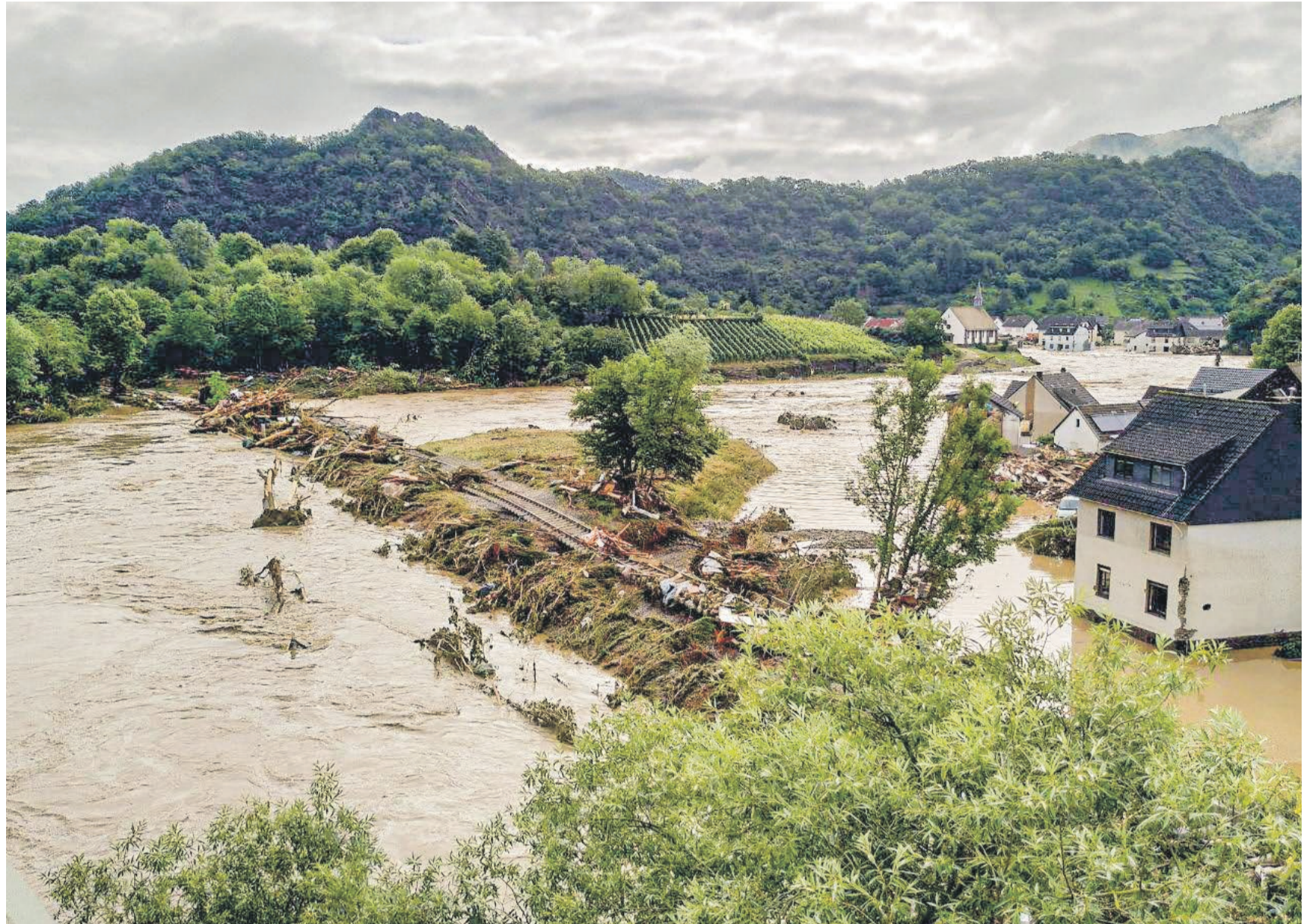
Hochwasser in Altenahr-Altenburg – auf derartige Situationen sollten sich Bürgerinnen und Bürger vorbereiten.
