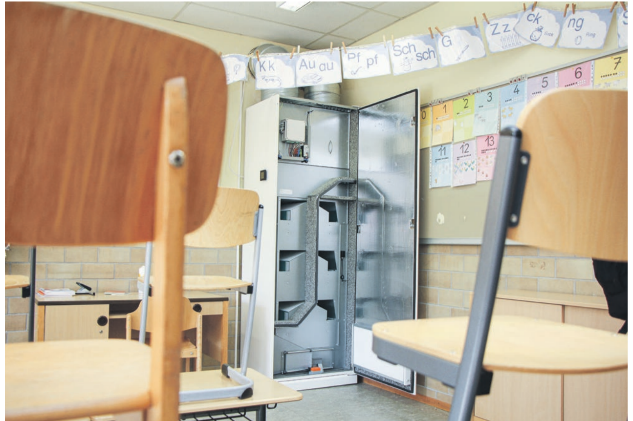
Stationäre Lüftungsanlagen sorgen für den Luftwechsel in den Klassenzimmern.
