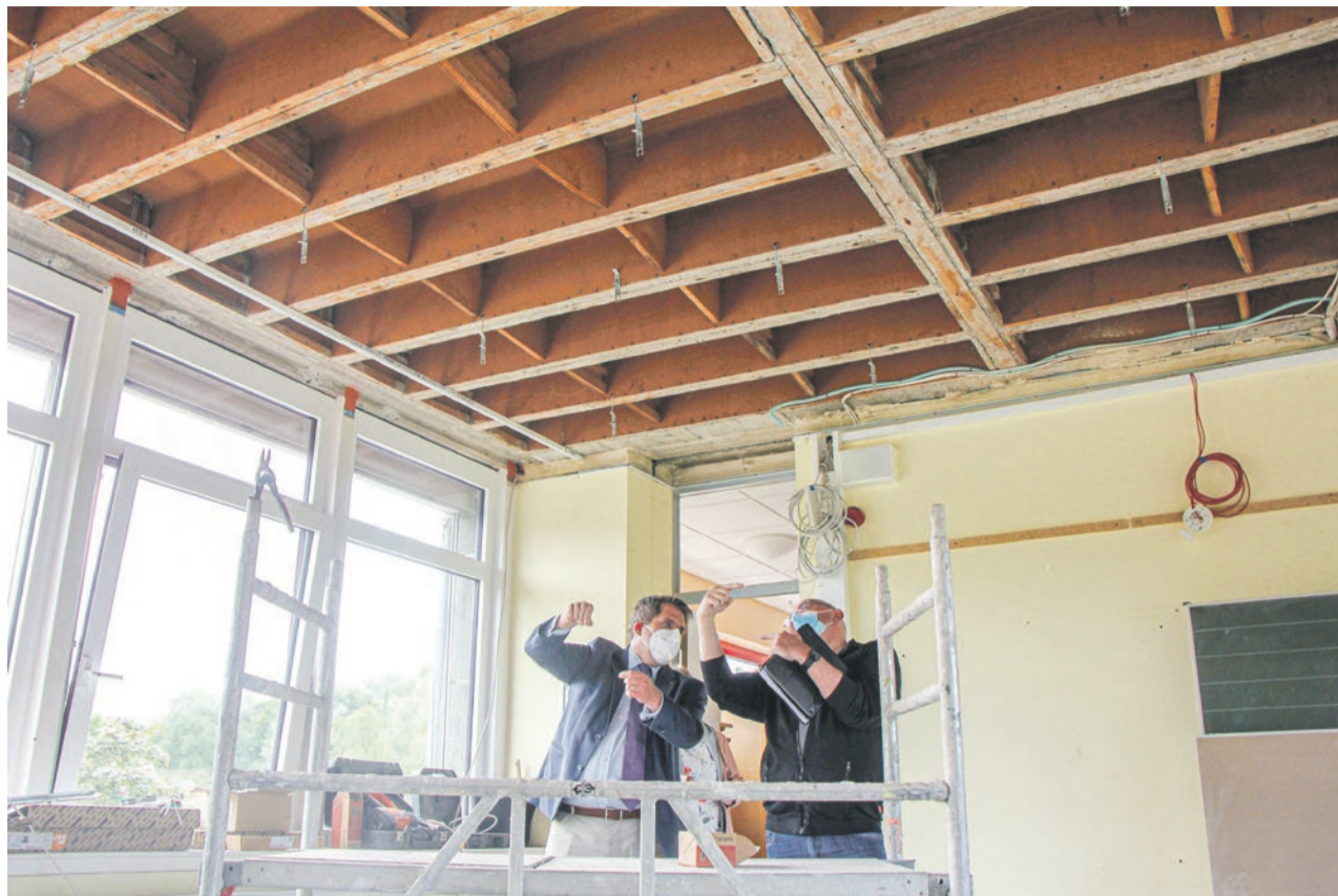
Die Sanierung von Zimmerdecken und der Einbau moderner Beleuchtungstechnik an der Waldschule in Neustadt standen auf dem Sommer-Bauplan des Kreises. Der Erste Kreisbeigeordnete Marian Zachow erörtert mit Joachim Debus vom Fachdienst Technisches Gebäudemanagement den Fortschritt der Arbeiten. (Foto: Landkreis Marburg-Biedenkopf)
