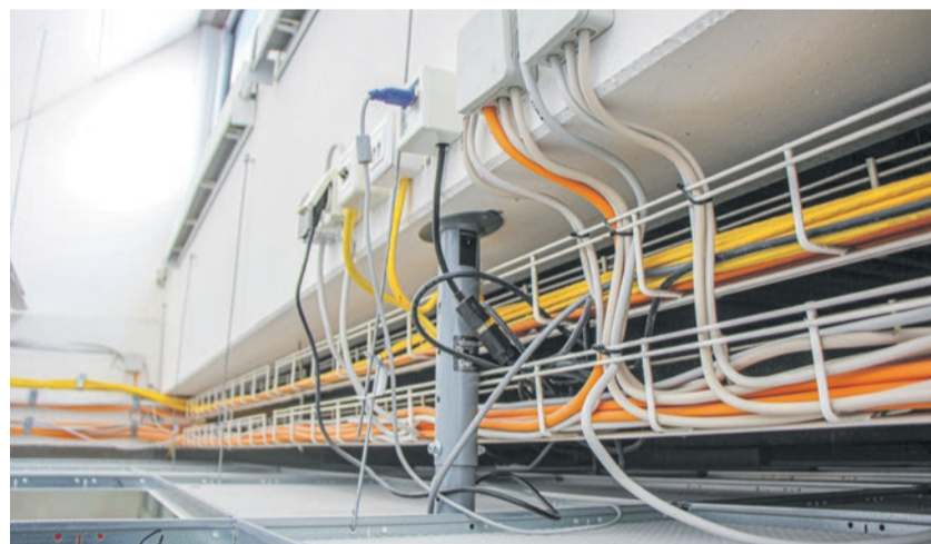
Obwohl eigentlich Wireless, also kabellos, sind für das W-LAN in den Schulen hinter den Kulissen doch viele Meter Kabel nötig, um das Internet-Signal in der Schule zu verteilen, damit Schülerinnen und Schüler sowie Lehrkräfte digitale Endgeräte und das Internet kabellos nutzen können. (Foto: Landkreis Marburg-Biedenkopf)
