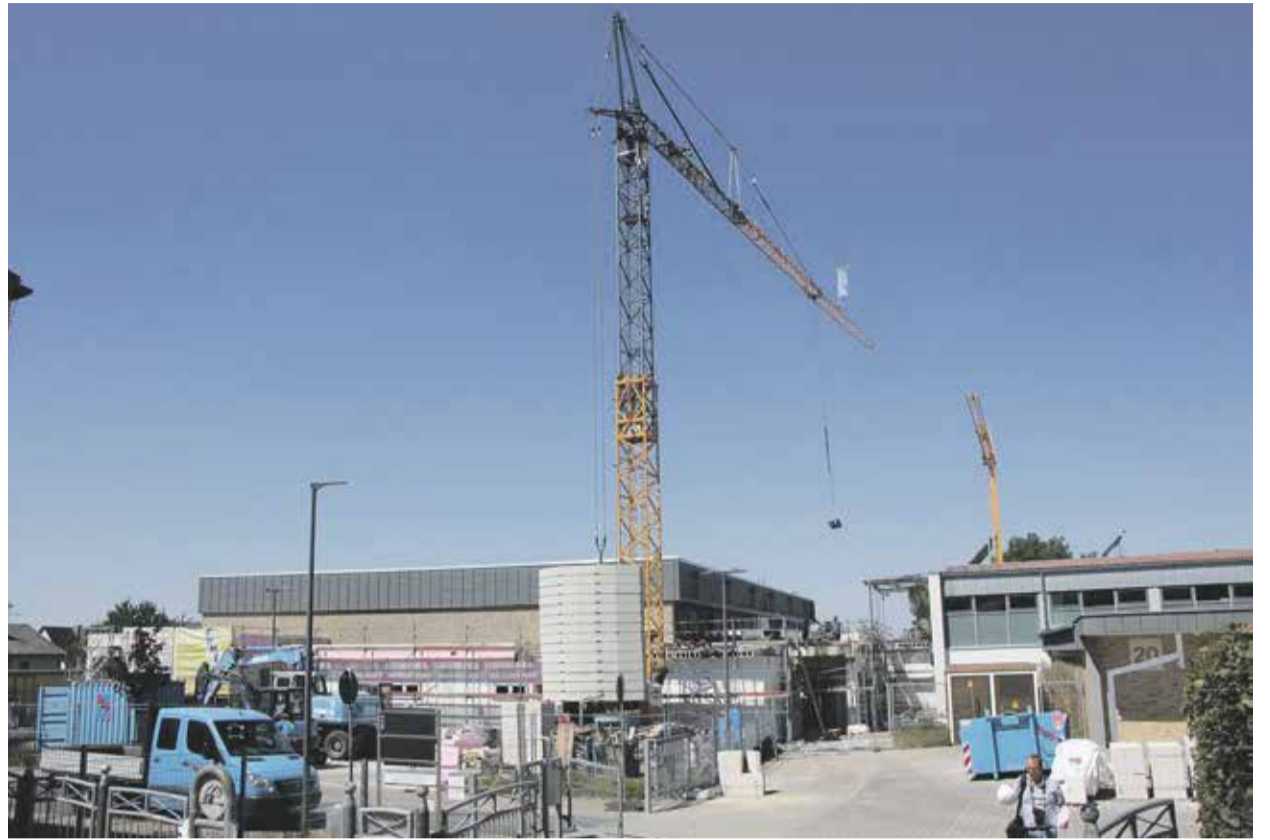
Ferienzeit ist Bauzeit: So auch hier an der Alfred-Wegener-Schule in Kirchhain.
