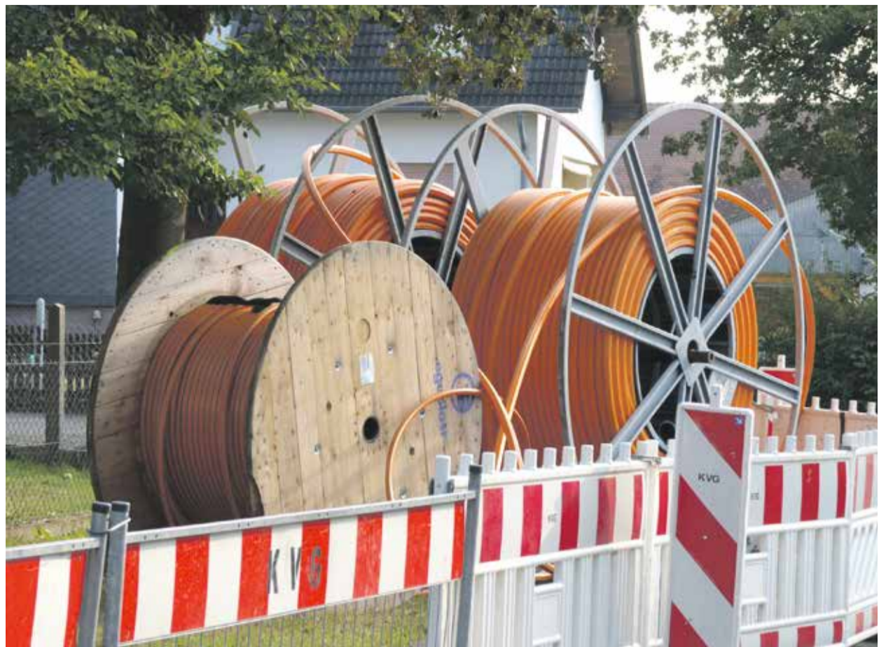
Orangefarbene Kabel zeugen vom Verlegen der Glasfaserleitungen im Kreis Marburg-Biedenkopf
