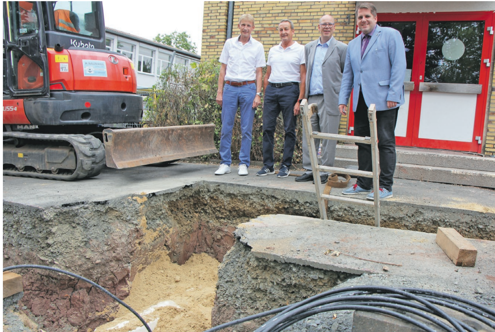
An der Alfred-Wegener-Schule wird seit dem neuen Schuljahr Fernwärme genutzt. Damit die an der Schule auch ankommt, braucht es Leitungen. Reiner Röder (Fachbereichsleiter Schule und Gebäudemanagement des Kreises), Andreas Kühn (stellvertretender Schulleiter an der Alfred-Wegener-Schule), Dr. Andreas Brors (Geschäftsführer der EAM Natur Energie) sowie der Erste Kreisbeigeordnete und Schuldezernent Marian Zachow machen sich einen Eindruck von den Bauarbeiten. (Foto: Landkreis Marburg-Biedenkopf)
