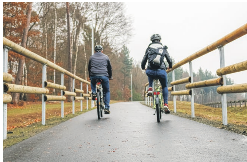
Rund 800 Meter lang ist der neue Radweg an der K 92 in Stadtallendorf. Der Weg schafft eine direkte Verbindung zwischen DAG-Gelände und Stadtzentrum. (Foto: Jennifer Hartwich)
